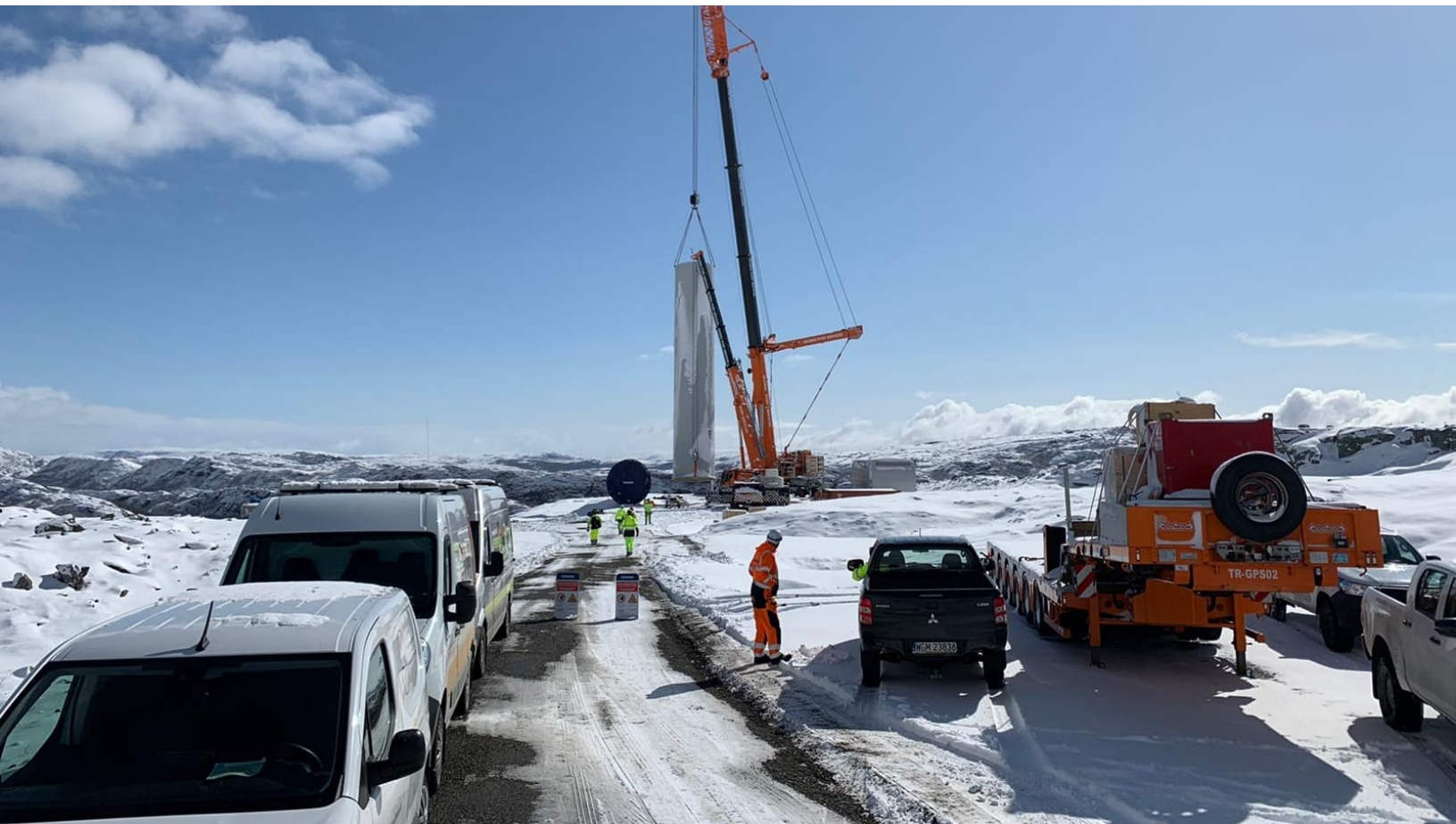
Første del av tårnet til den første turbinen på plass i Kvenndalsfjellet vindpark
